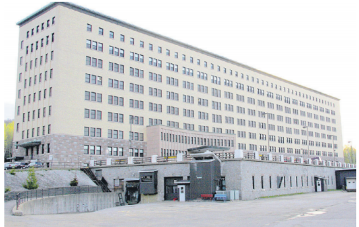
Le 12 novembre dernier, au Centre de service de Rivière-Rouge, l'ascenseur #2 s'est arrêté sur les freins d'urgence avec quatre employés à bord. (Photo L'Info de la Lièvre – Archives)
