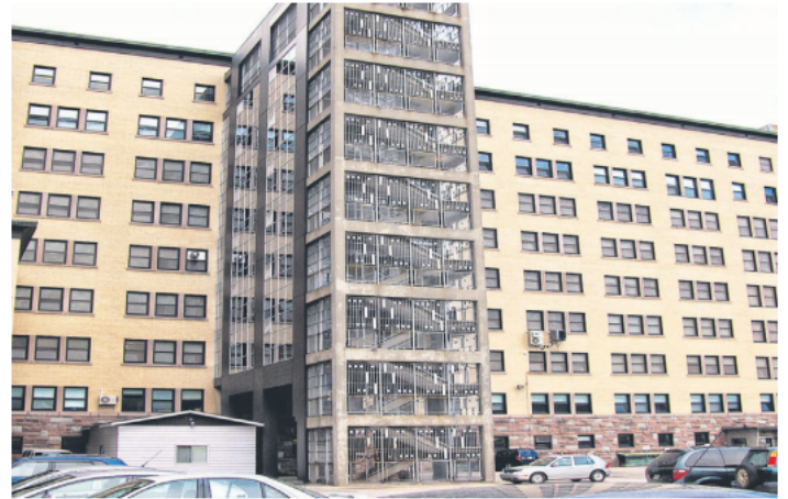
La situation du service en soirée de la cafétéria du point de services de Rivière-Rouge relève du manque d'effectifs, une situation qui doit se résorber selon la direction générale du CISSS des Laurentides. (Photo L'Info du Nord - Archives)
