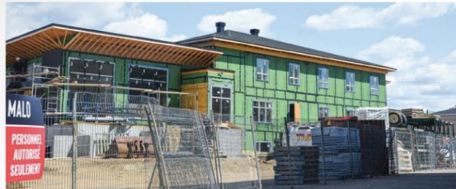
Les travaux de construction vont bon train à côté de l'ancienne église Sainte-Paule.
